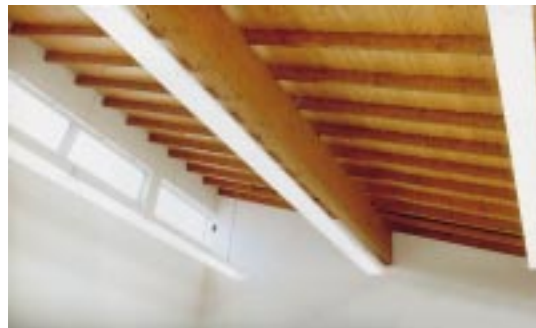
在車間根據日光控制的成排照明
