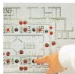
故障和操作信號 ：通過雙值入的輔助信號開關來記錄。
