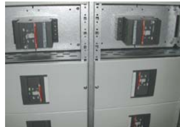
装置单元两列平排(可节省回路出线的空间)
