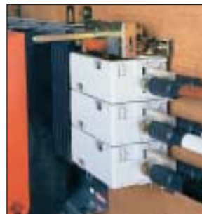
图 3： 电缆连接件 (侧边)
