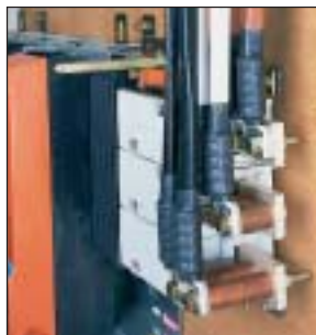
图 2： 电缆连接件 (上部)
